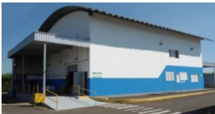
Figura 13 - Prédio de operação
